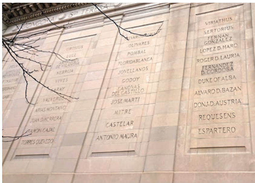
Fachada sur del edificio, con los nombres labrados en piedra de numerosos personajes históricos.
